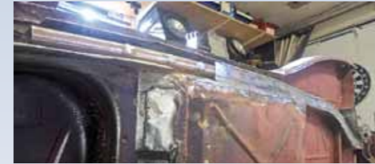
Rungon vahvistus RHS-putkella.
